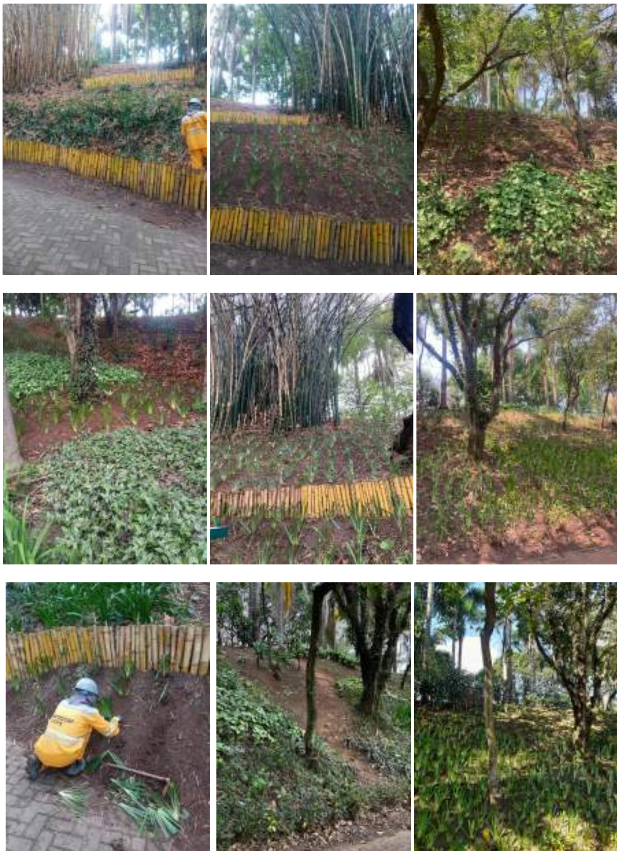
Figura 25: Limpeza e plantio de Iris em taludes
