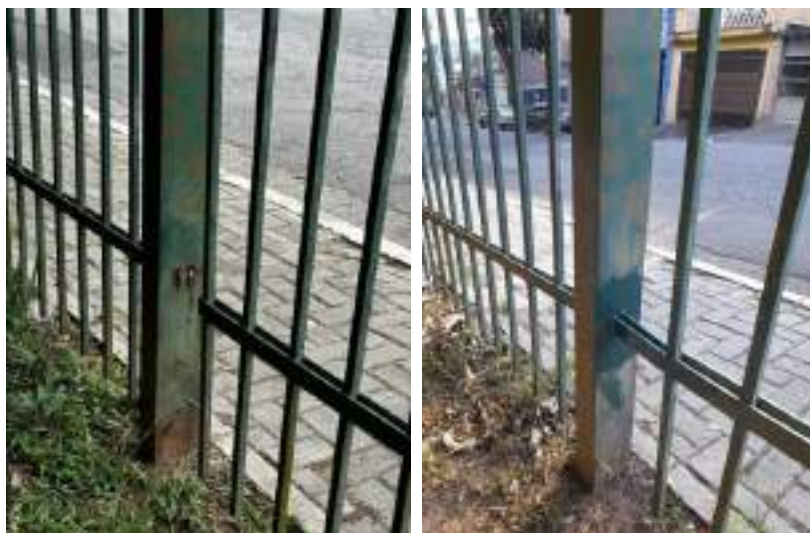
Figura 37: Soldagem do gradil
